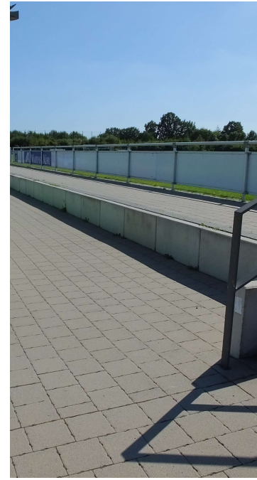
Umlaufende Befestigung und Verwehungsschutz
